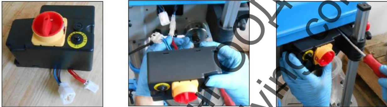
Фигура 7 – Фази на монтажа на електрическото табло
